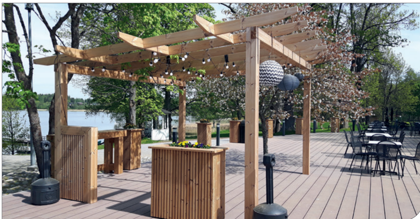
Bild 32. ThermoWood® limträbalkar i pergolastruktur.
