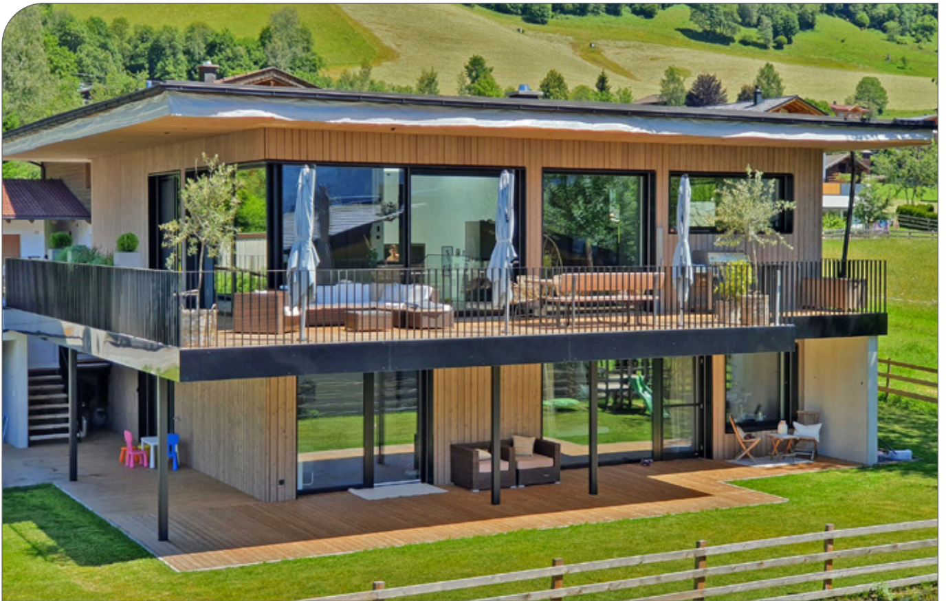
Bild 75. ThermoWood® fasadbeklädnad (Österrike).
