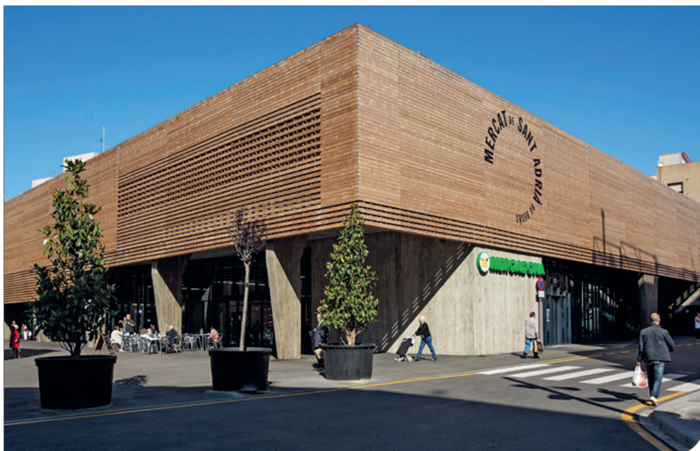
Bild 64. ThermoWood® fasadbeklädnad på ett köpcentrum (Spanien).
