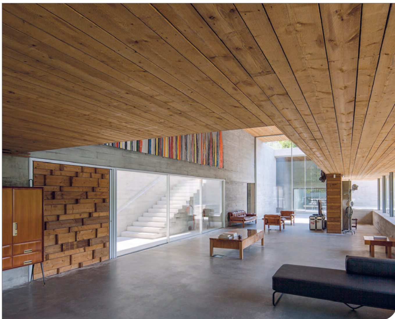
Bild 37. ThermoWood®-tak i Portugal.
